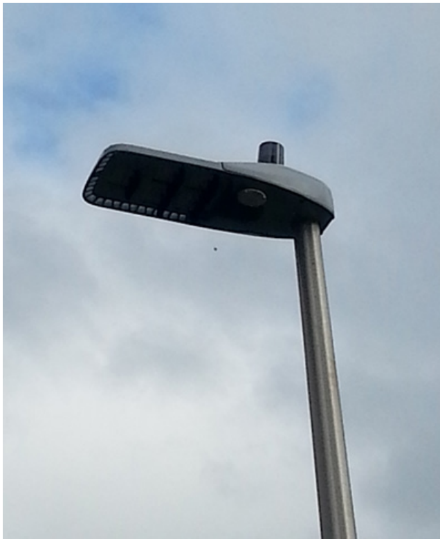
A node on the lantern collects data on column performance Datenübertragung über Steckdose
