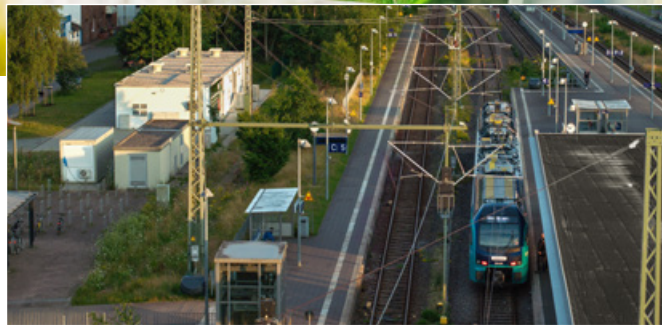
New equipment for catenary islands Neuartige Oberleitungsinselanlage
