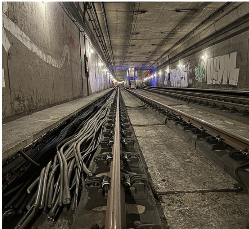
Cable dismantling in the tunnel Kabelrückbau im Tunnel
