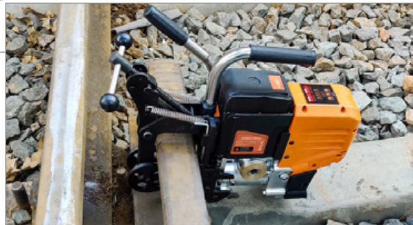
Rail drilling operations in snowy weather Gleisbohrarbeiten bei Schnee
