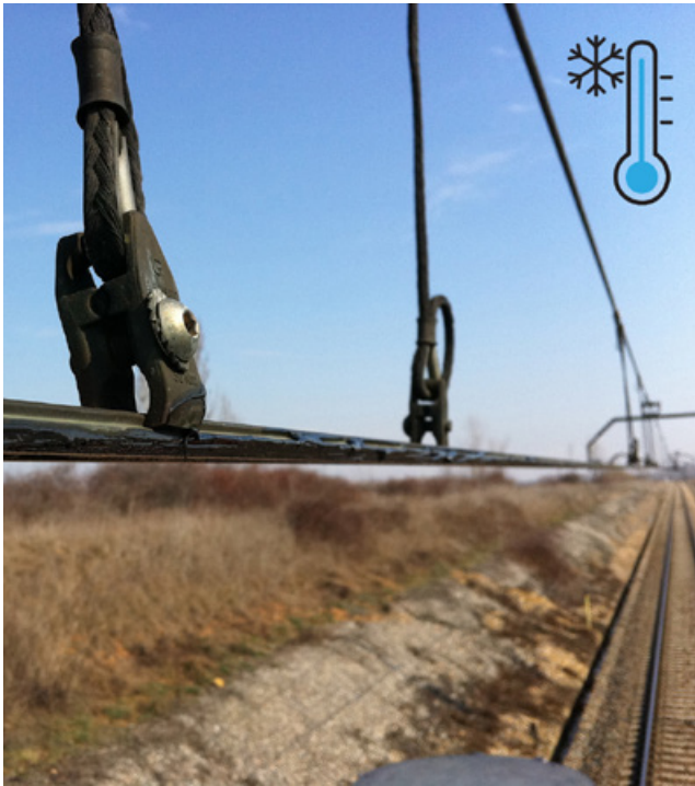
Catenary overhead line greased and protected from "ice sleeve" Oberleitung geschmiert und vor „Eismantel“ geschützt
