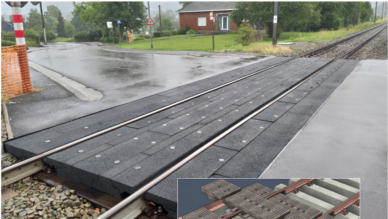
Reprocover - level crossing Reprocover – Bahnübergang
