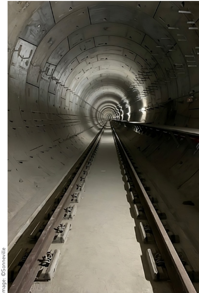
Built-in LVT-system, Mumbai Eingebautes LVT-System, Mumbai
