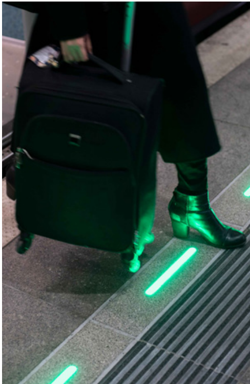
Door release via Illuminated Platform Edge Türfreigabe durch Leuchtende Bahnsteigkante
