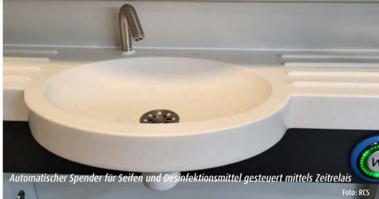
Automatischer Spender für Seife und Desinfektionsmittel gesteuert mittels Zeitrelais
