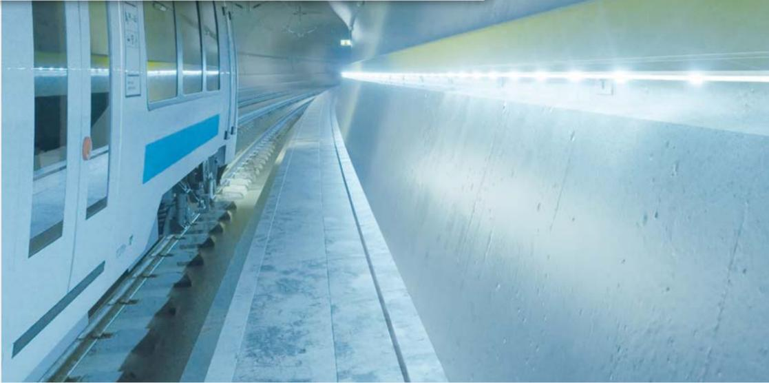
LED-beleuchtetes Handlaufsystem HRS aus glasfaserverstärktem Kunststoff
