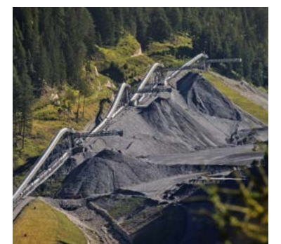
Förderbandanlage am Brenner Basistunnel (Deponie Padastertal)
