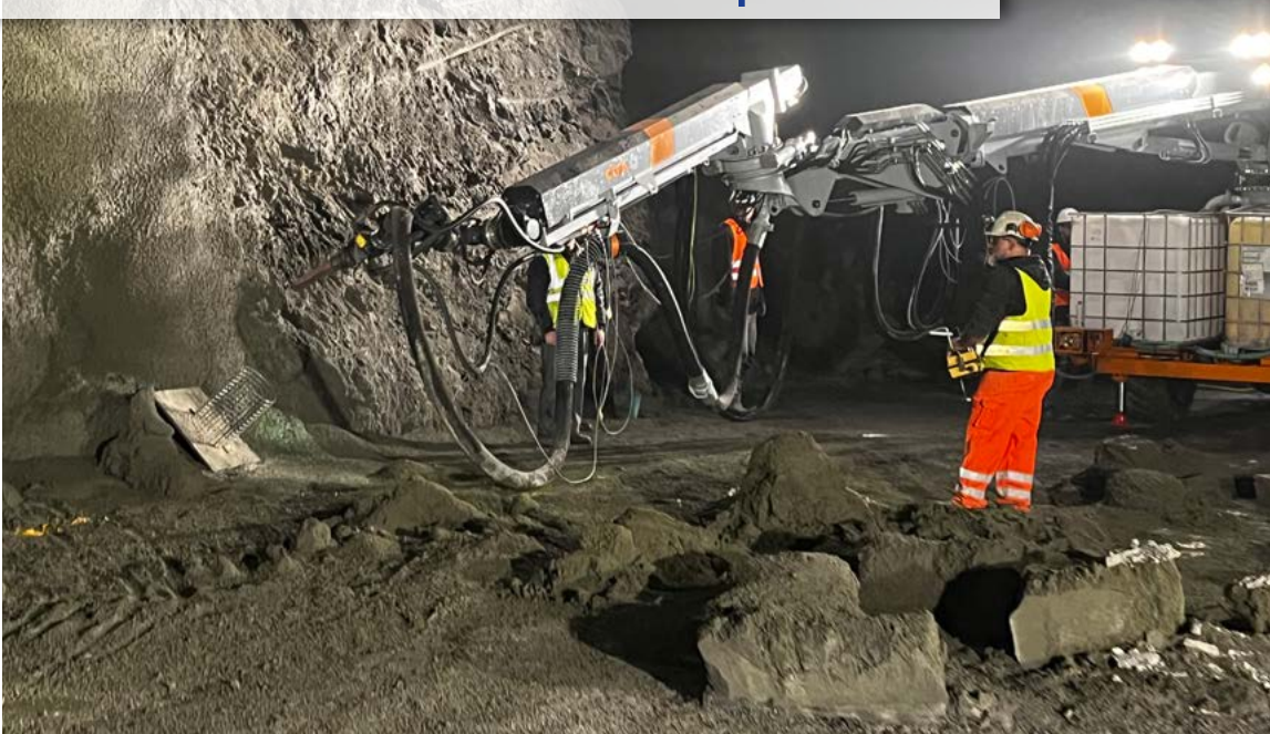
Spritzbetonpumpe Mamba im Tunneleinsatz
