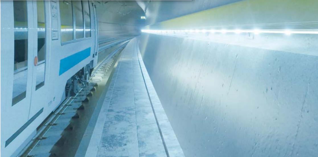
Système de main courante HRS éclairé par LED en plastique renforcé de fibres de verre
