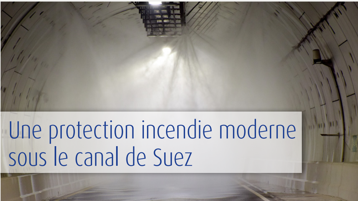
Test de recevabilité avec essai de pulvérisation pendant la mise en service
