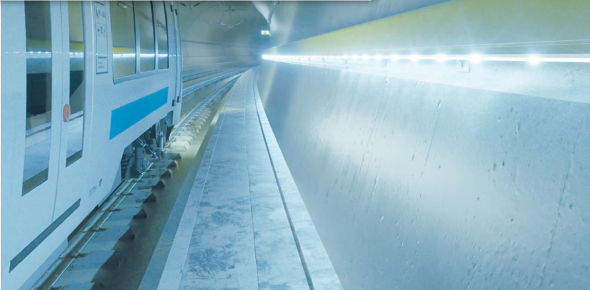
LED-beleuchtetes Handlaufsystem HRS aus glasfaserverstärktem Kunststoff
