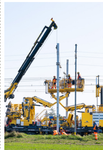
Le train TSO rénove les caténaires du réseau 1 500 volts
