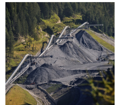
Förderbandanlage am Brenner Basistunnel (Deponie Padastertal)
