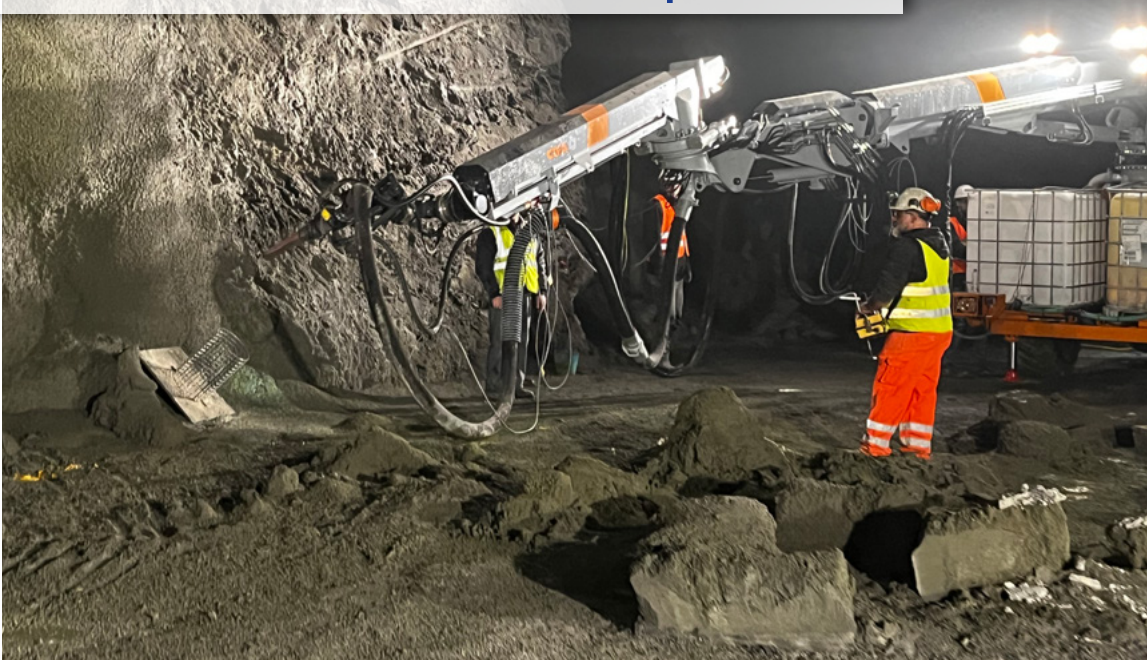
Spritzbetonpumpe Mamba im Tunneleinsatz
