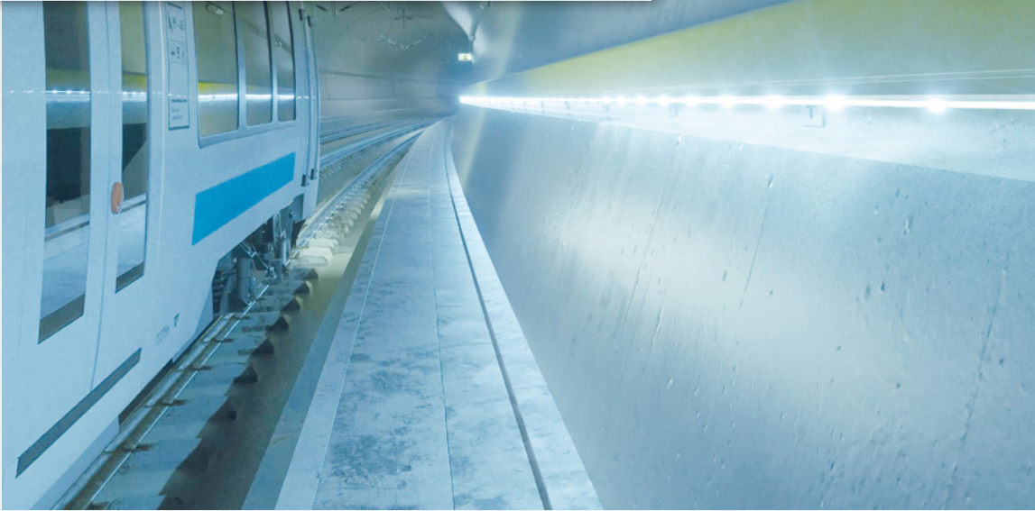
LED-beleuchtetes Handlaufsystem HRS aus glasfaserverstärktem Kunststoff
