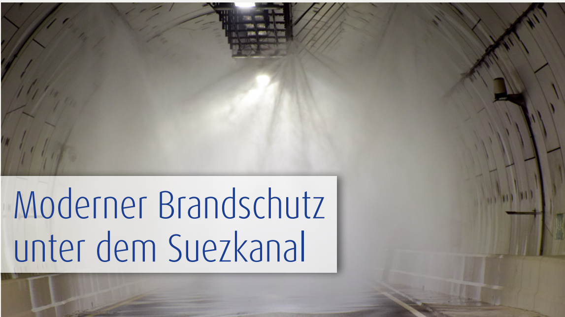
Abnahmetest mit Sprühversuch während der Inbetriebnahme
