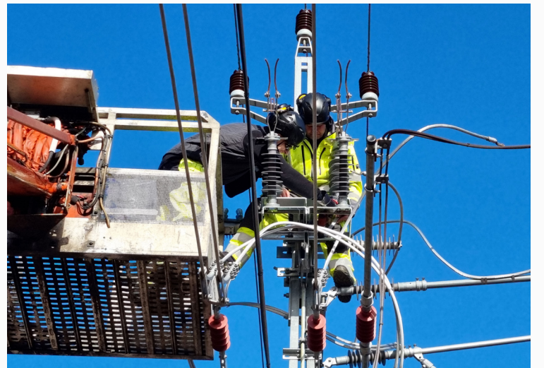
Installation de l'appareil de commutation en plein air de Hughes.
